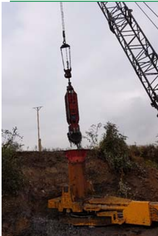
Bauausführung der neuen GB, Firma Hölscher
